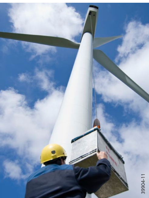
Bis 180 m Hakenweg für die Wartung von Windkraftanlagen
